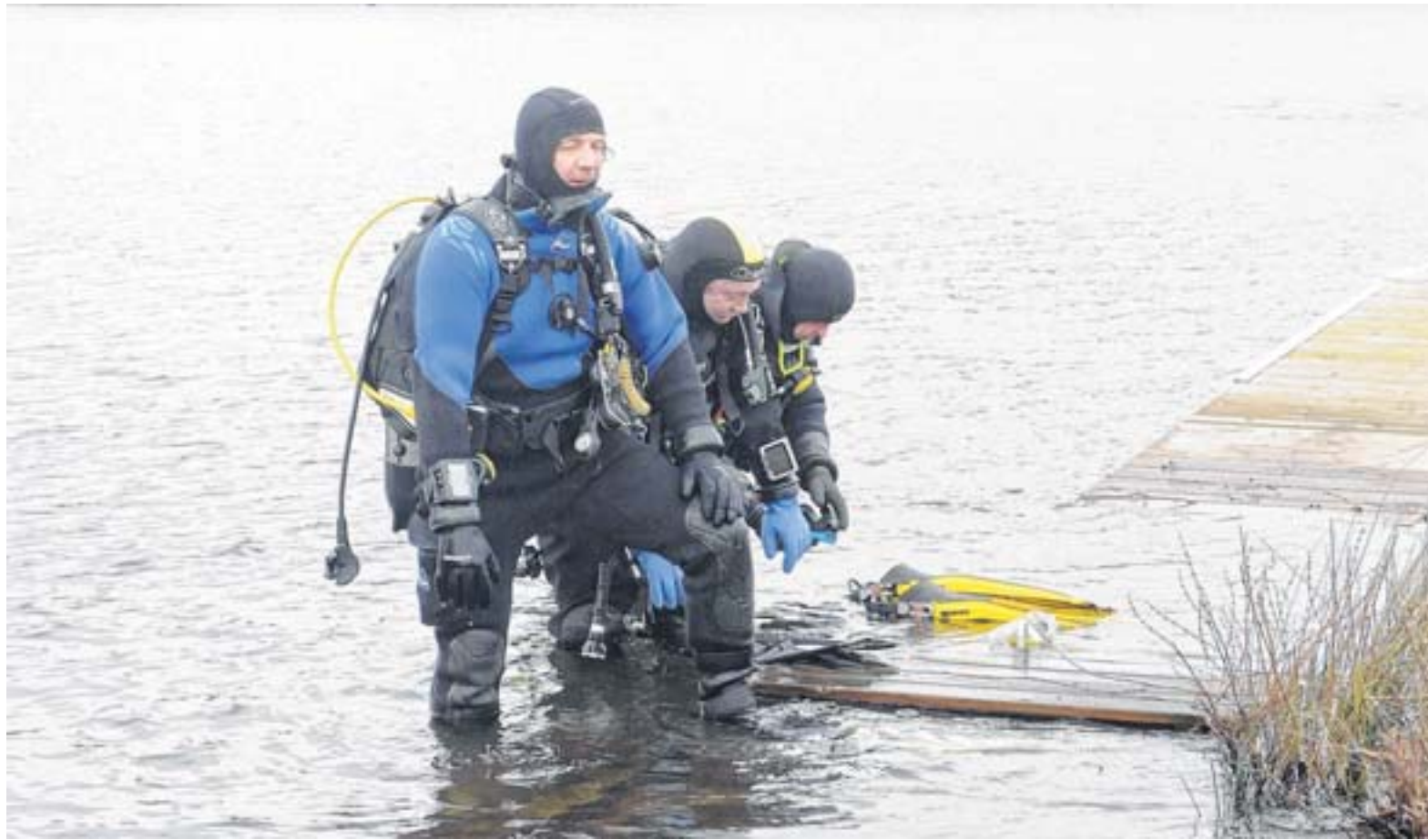
In einer Tiefe von acht Metern werden die Taucher ein sechs Meter hohes und zehn Meter breites Riff errichten.
